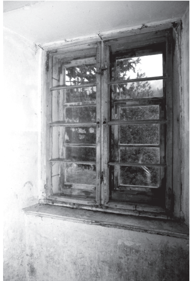
Abb. 33: Wohnhaus, Gang 11, Detail: Sprossenfenster von 1837. Neg. Nr. 2.2
