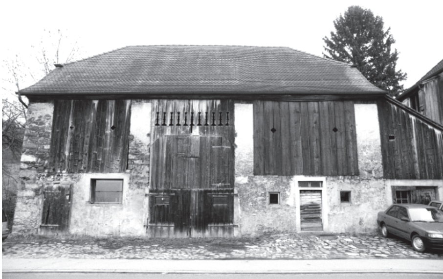
Abb. 4: Stallscheune: Westfassade. Neg. Nr. 1.2
