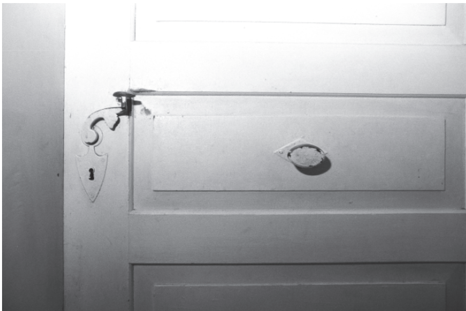
Abb. 36: Wohnhaus, Stube 12, Detail: Türgestaltung von 1837; Tür nach Raum 13. Neg. Nr. 1.33
