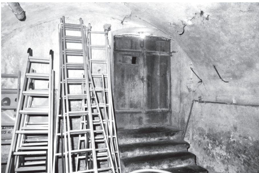
Abb. 25: Wohnhaus, Keller 03 von 1837: Gewölbekeller; Südteil mit Zugang. Neg. Nr. 1.23
