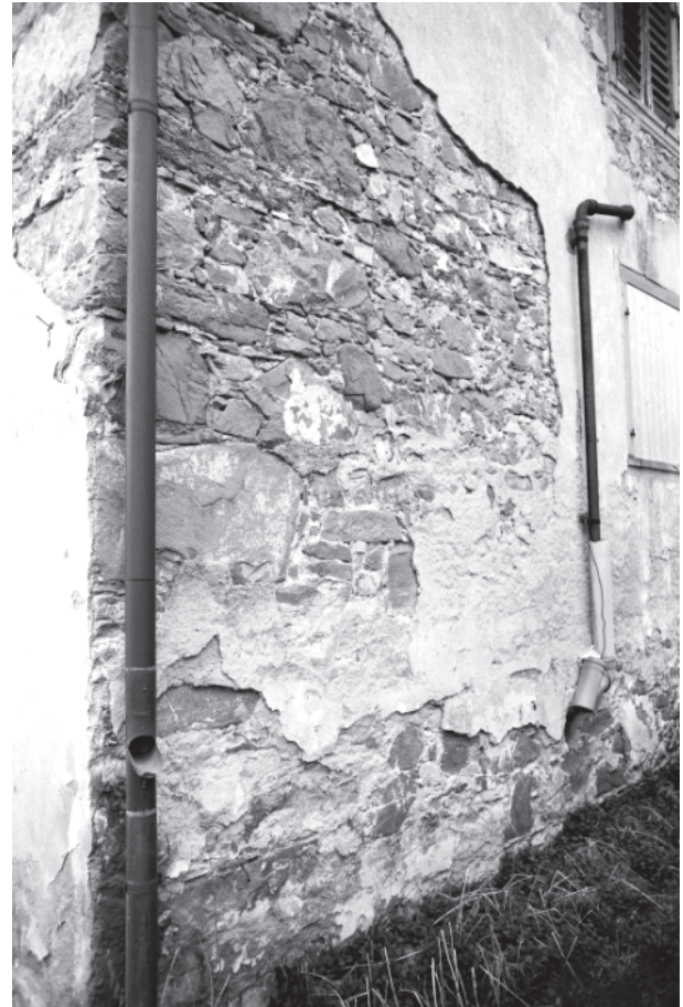
Abb. 15: Wohnhaus, Ostfassade, Südostecke, Detail: Bruchstein-Mauerwerk und zugemauerte Lüf- tungsöffnung. Neg. Nr. 1.12
