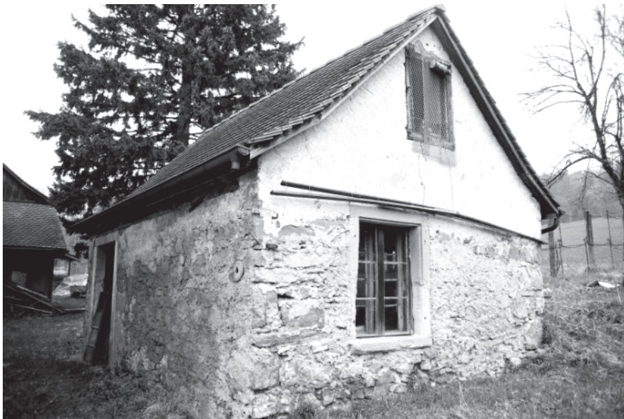
Abb. 12: Waschhaus: Südwest- ansicht. Neg. Nr. 1.10
