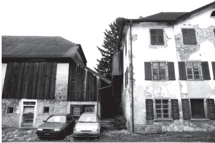
Abb. 3: Stallscheune / Wohnhaus: Westfassade. Neg. Nr. 1.1
