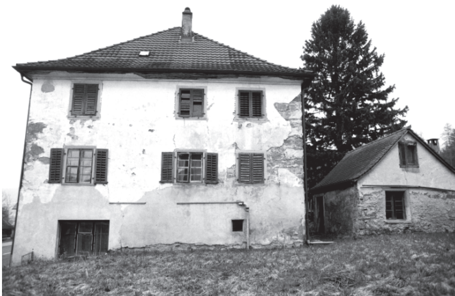
Abb. 13: Wohnhaus und Wasch- haus: Südfassade. Neg. Nr. 1.11
