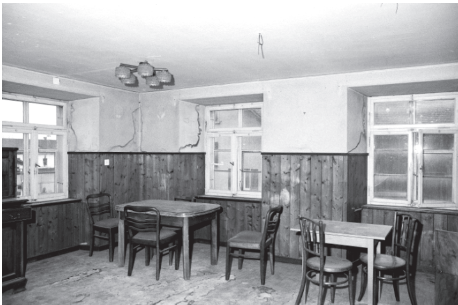
Abb. 34: Wohnhaus, Stube 12, Süd- westteil: Innenausbau im 20. Jh. partiell erneuert.
