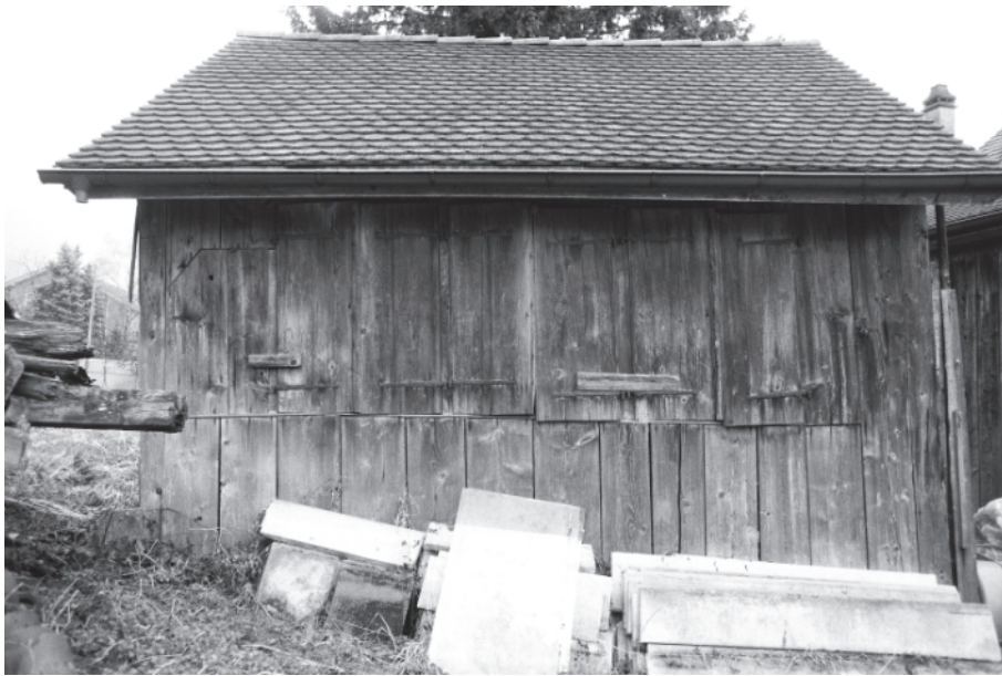
Abb. 8: Schützenhäuschen: Nordfassade mit ge- schlossenen Holzläden zur Ausschuss-Front. Neg. Nr. 1.6
