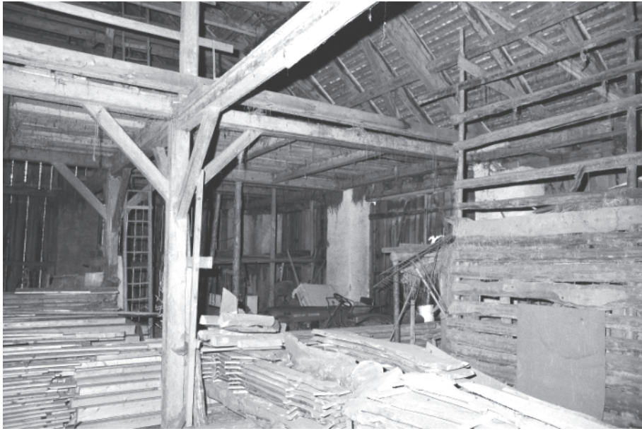
Abb. 59: Scheune von 1837, Ober- geschoss: Scheunenraum; Südeinsicht. Neg. Nr. 2.22
