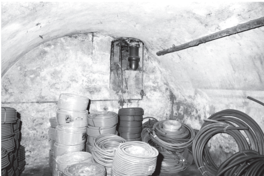
Abb. 24: Wohnhaus, Keller 03 von 1837: Gewölbekeller; Nordteil mit Luzide. Neg. Nr. 1.22
