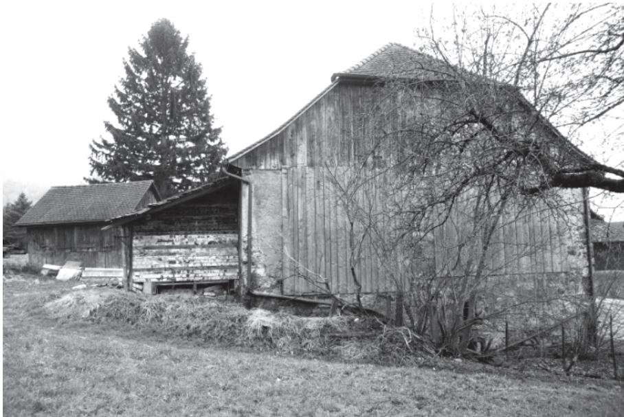
Abb. 6: Stallscheune: Nordfassade. Neg. Nr. 1.4
