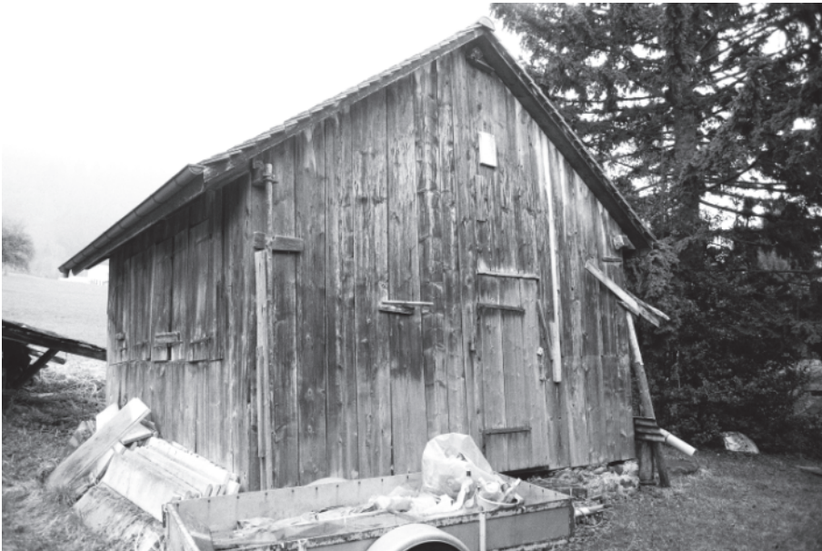
Abb. 9: Schützenhäuschen: Nordwestansicht. Neg. Nr. 1.7
