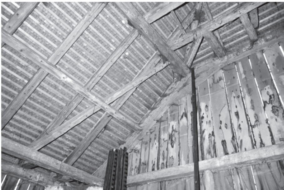
Abb. 57: Scheune von 1837, Nord- westecke: Dachstuhlkon- struktion. Neg. Nr. 2.20
