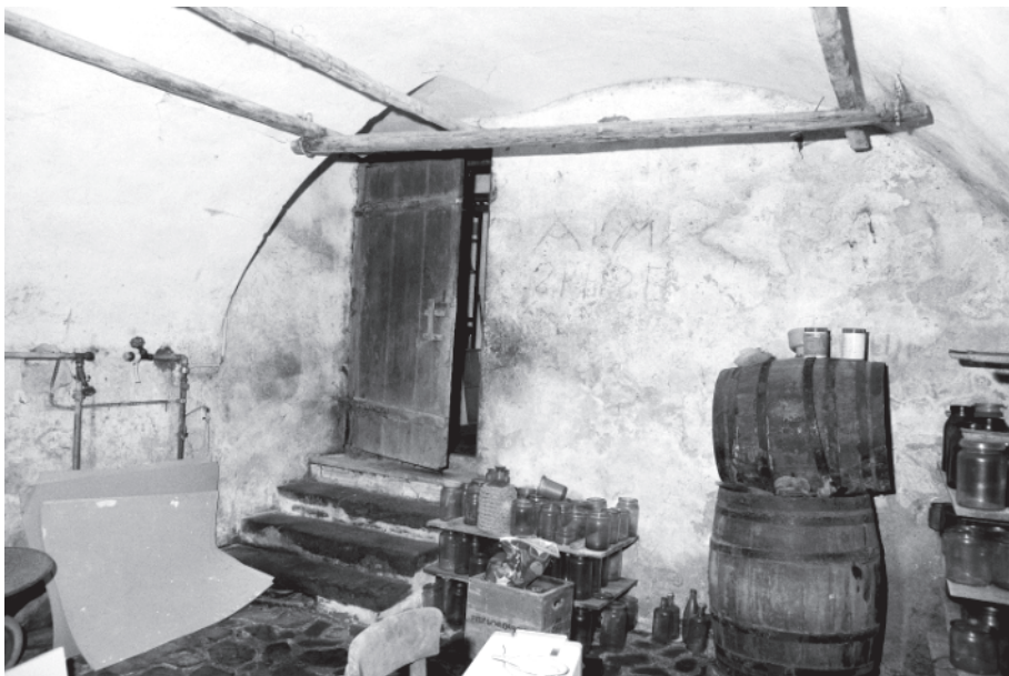
Abb. 27: Wohnhaus, Keller 04 von 1837: Gewölbekeller; Nordteil mit Zugang. Neg. Nr. 1.25
