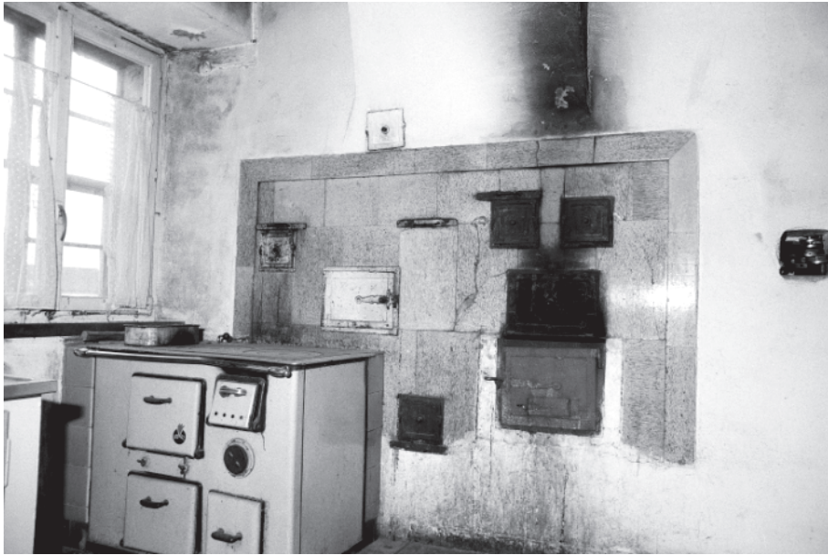
Abb. 41: Wohnhaus, Küche 18: Herdstelle vor der West- wand; Ofeneinfeuerung/ Kaminwand mit Ofenka- cheln des 19. Jh. der Firma Schädler, Nendeln verkleidet. Neg. Nr. 2.1
