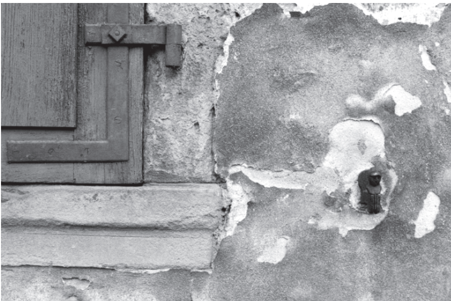
Abb. 19: Wohnhaus, Westfassade, Detail: Fenstergericht- gestaltung von 1837.
