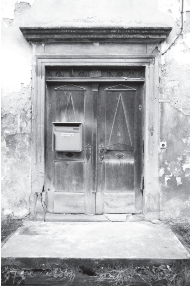
Abb. 17: Wohnhaus: Westfassade mit dekorativer eicher- ner Haustür von 1837. Neg. Nr. 1.15
