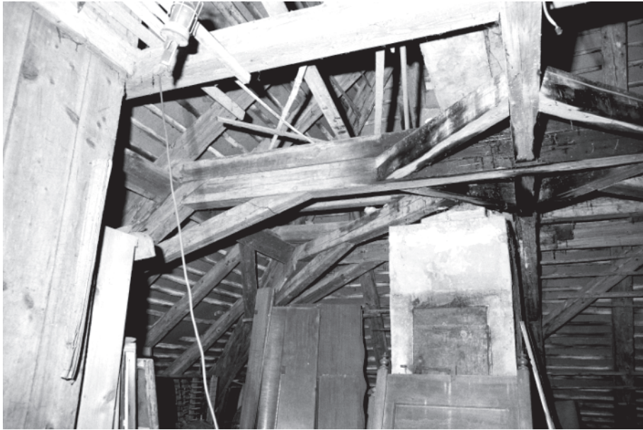
Abb. 53: Wohnhaus, Dachgeschoss, Dachstuhl von 1837, Südteil: Rauchkammer-Einbau, A. 20. Jh. Neg. Nr. 2.15
