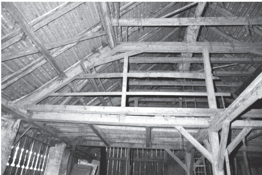
Abb. 58: Scheune von 1837: Dach- stuhlkonstruktion mit liegendem Binder. Neg. Nr. 2.21
