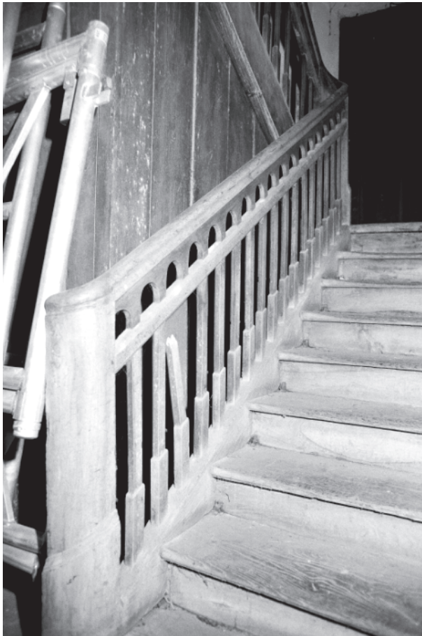
Abb. 21: Wohnhaus, Gang 01: Ostteil mit Treppengeländer in klassizistischer Art, von 1837. Neg. Nr. 1.18
