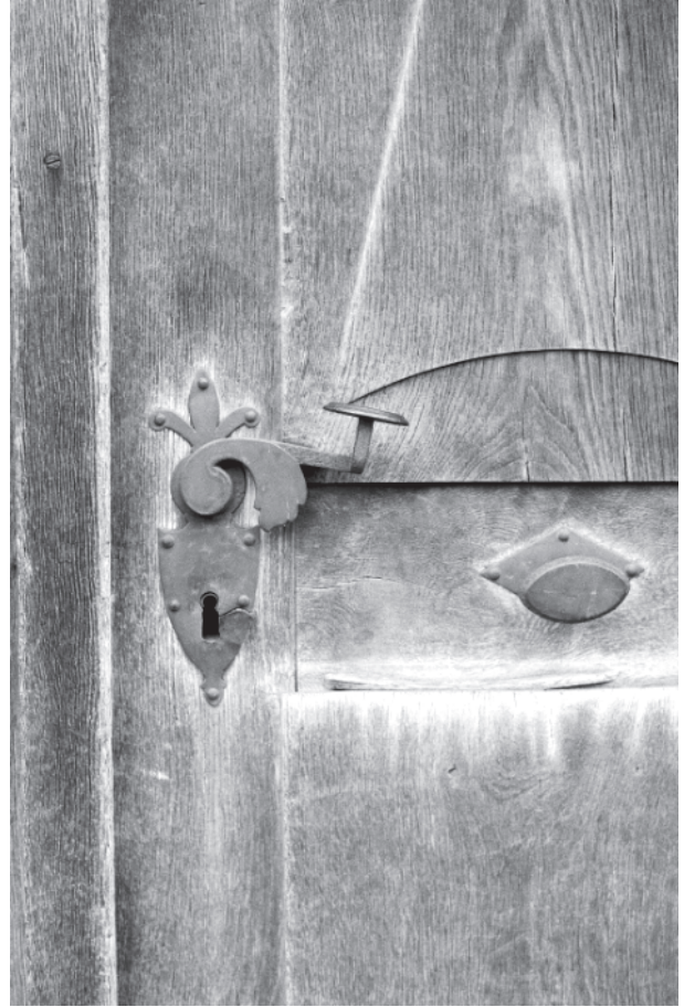
Abb. 18: Wohnhaus, Westfassade, Detail: Haustürbe- schläge und -gestaltung von 1837. Neg. Nr. 1.17
