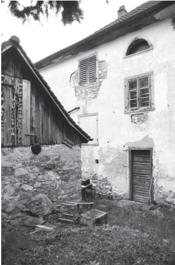
Abb. 14: Wohnhaus und Waschhaus: Nordostansicht / Ostfassade. Neg. Nr. 1.13
