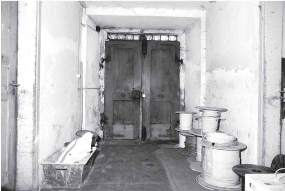
Abb 20: Wohnhaus, Gang 01 von 1837: Westteil mit Portal. Neg. Nr. 1.19
