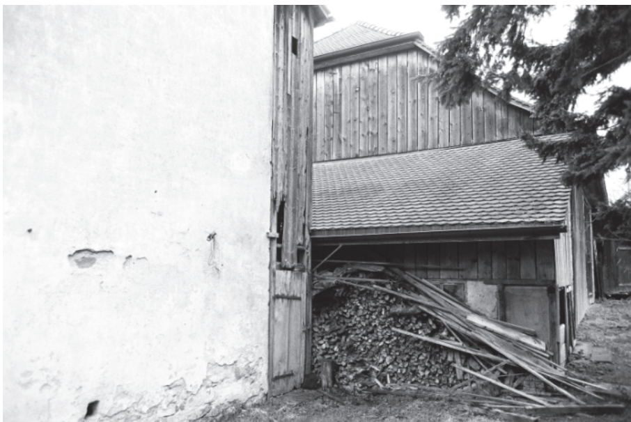
Abb. 16: Stallscheune: Südfassade mit Schopf-/Kleintierstall- anbau.
