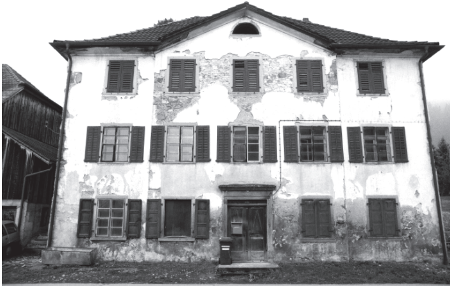
Abb. 2: Wohnhaus: Westfassade. Neg. Nr. 1.0
